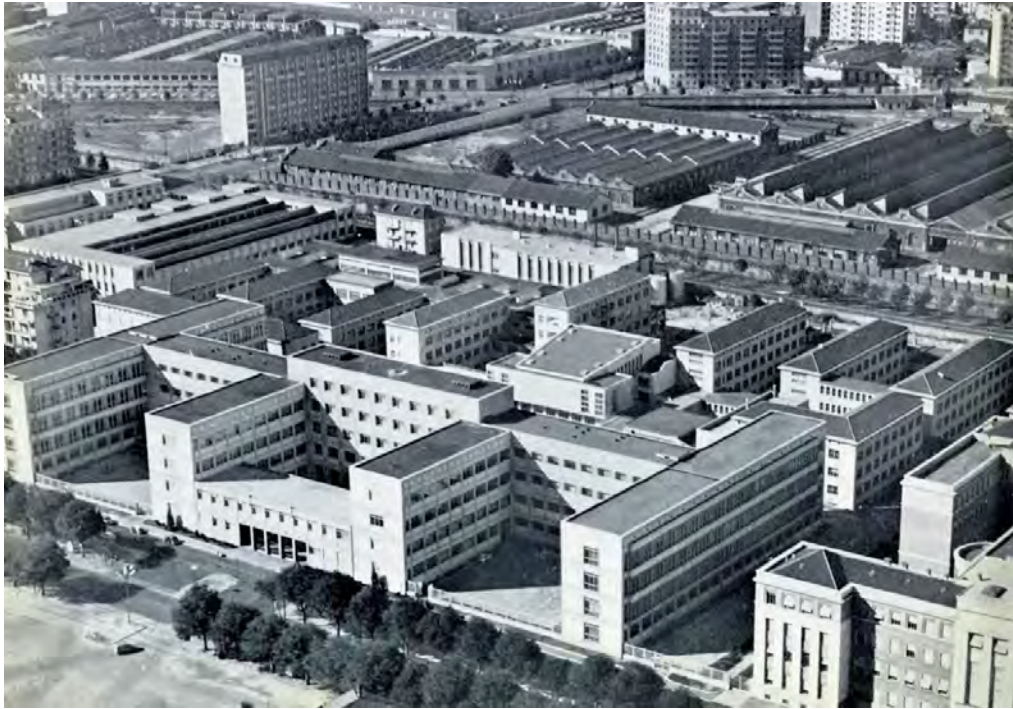
Figure 11. Aerial view of Politecnico Engineering Building, 1958 ('Politecnico di Torino. Nuova Sede', Provveditorato delle Opere Pubbliche per il Piemonte, Ufficio del Genio Civile di Torino).
